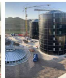
Installatie in aanbouw
